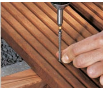
SPAX®-D nasadit rovně. Bez přerušení zašroubovat do roviny.
