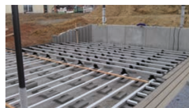
ilustrační obrázek 8% vyrovnání sklonu
