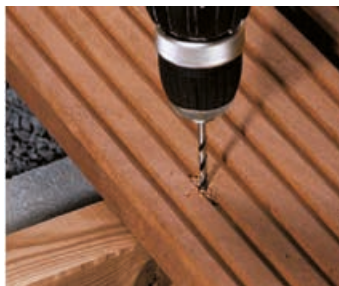
Prkno a spodní konstrukci předvrtat ø 3,5 mm.
